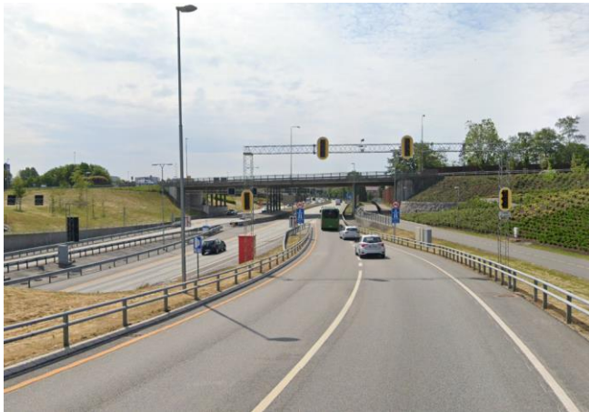
Figur 9-34: Rampekontroll ved Schancheholen i Stavanger
