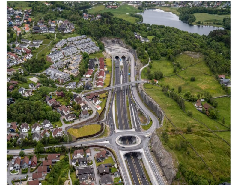
Eiganestunnellen i Stavanger sett fra nord, ved Tasta. Etter åpningen økte biltrafikken på E39 her med 16 prosent – mens byvekstavtalen med fylkeskommunen og staten forutsetter nedgang i biltrafikken. Foto: Jarle Aasland, Stavanger Aftenblad
