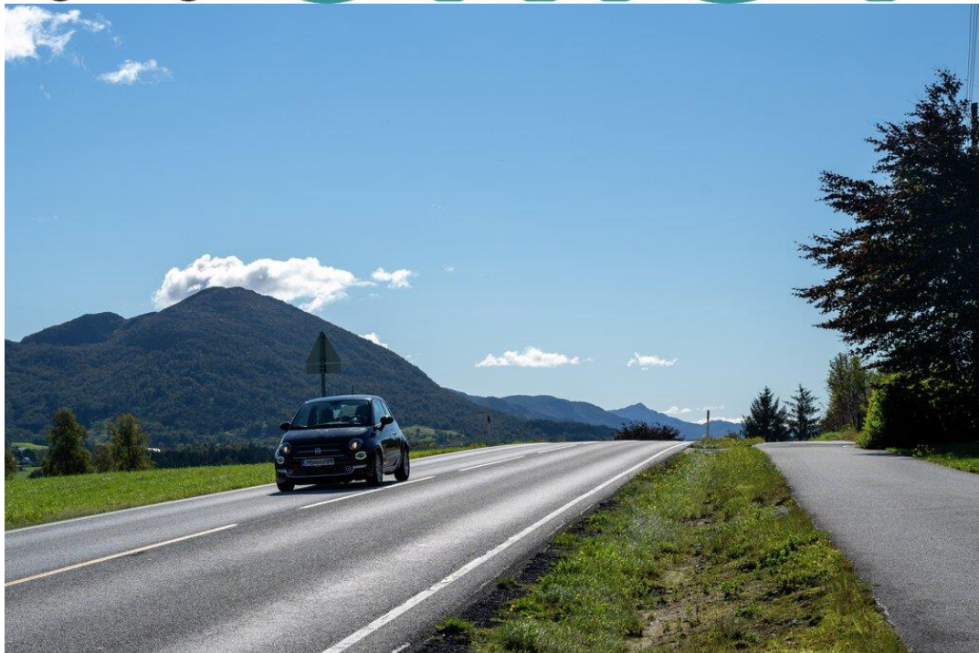
Foto: Bård Asle Nordbø / Statens vegvesen
