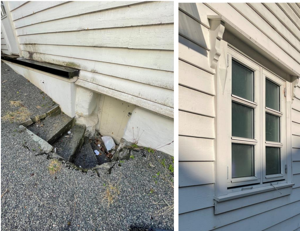
Figur 2-17 Detaljer. Kjellernedgang og -dør til venstre. Vindusomramning til høyre. Foto: Asplan Viak.
