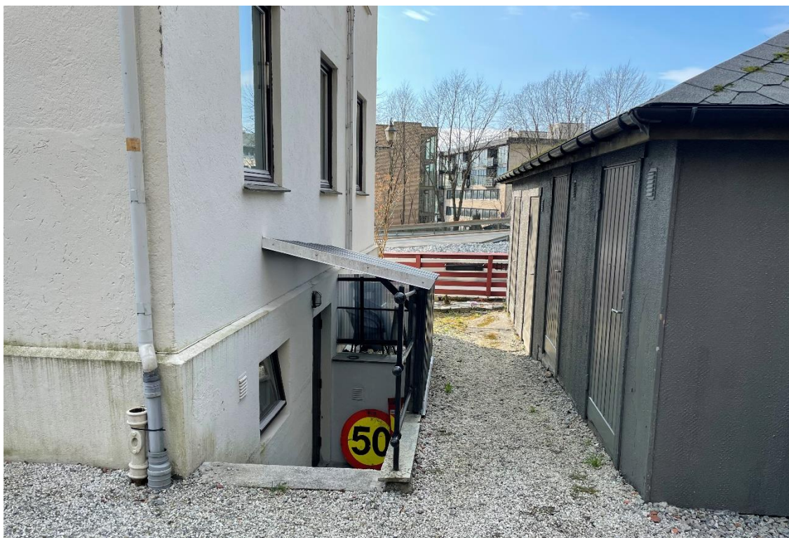
Figur 5-13: Nedgang til kjellerleilighet i nr. 64 på gavlen mot nord. Fellesbygg med boder til høyre. Foto: Asplan Viak.
