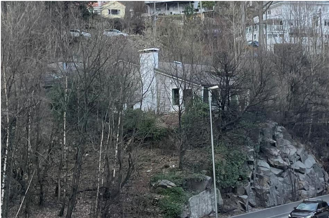
Figur 7-12: Fotografi av sør- og østfasaden. Foto: Asplan Viak.
