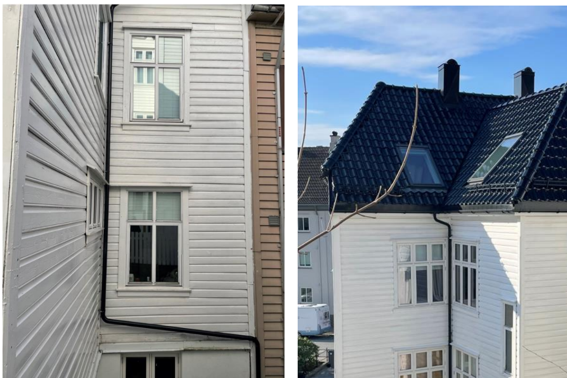
Figur 3-20: Nordveggen av bygningen er sammenbygget med nabobygget mot nord til venstre. Tak, renner og nedløp samt piper til høyre. Foto: Asplan Viak.
