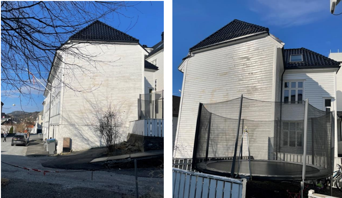
Figur 3-21: Bygningen sett fra sør med tilbygget til høyre. Foto: Asplan Viak.
