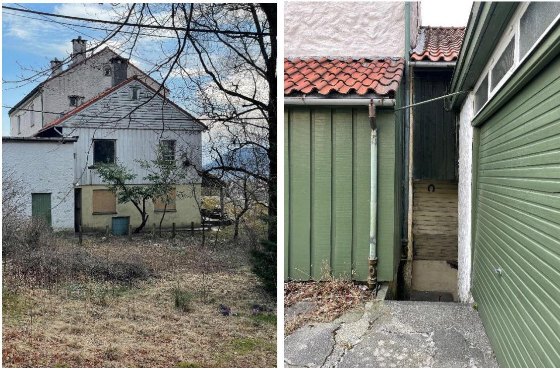
Figur 6-14 T.v.: Fotografi av tilbyggets nordfasade. T.h.: Fotografi av trapp fra dobbeltgarasje og ned i hage (ved tilbygg). Foto: Asplan Viak.
