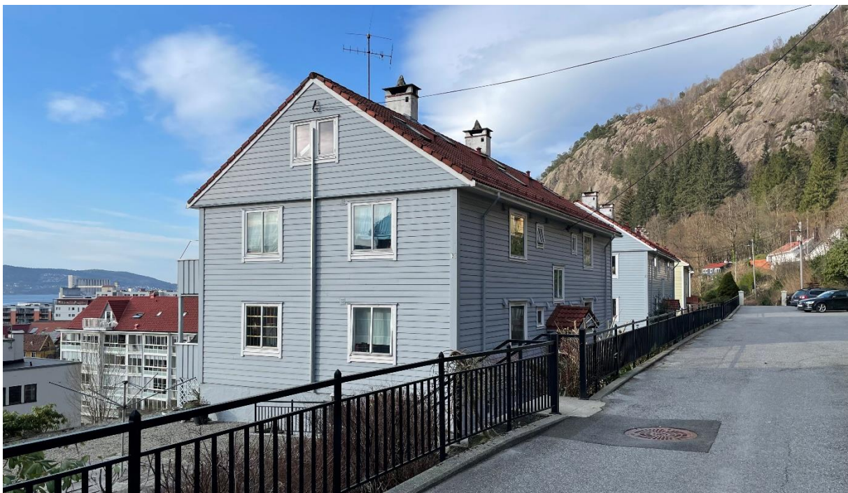
Figur 4-6: Amalie Skrams vei nr. 29 sett mot nord. Nr. 31 sees som neste bygg i rekken. Foto: Asplan Viak.
