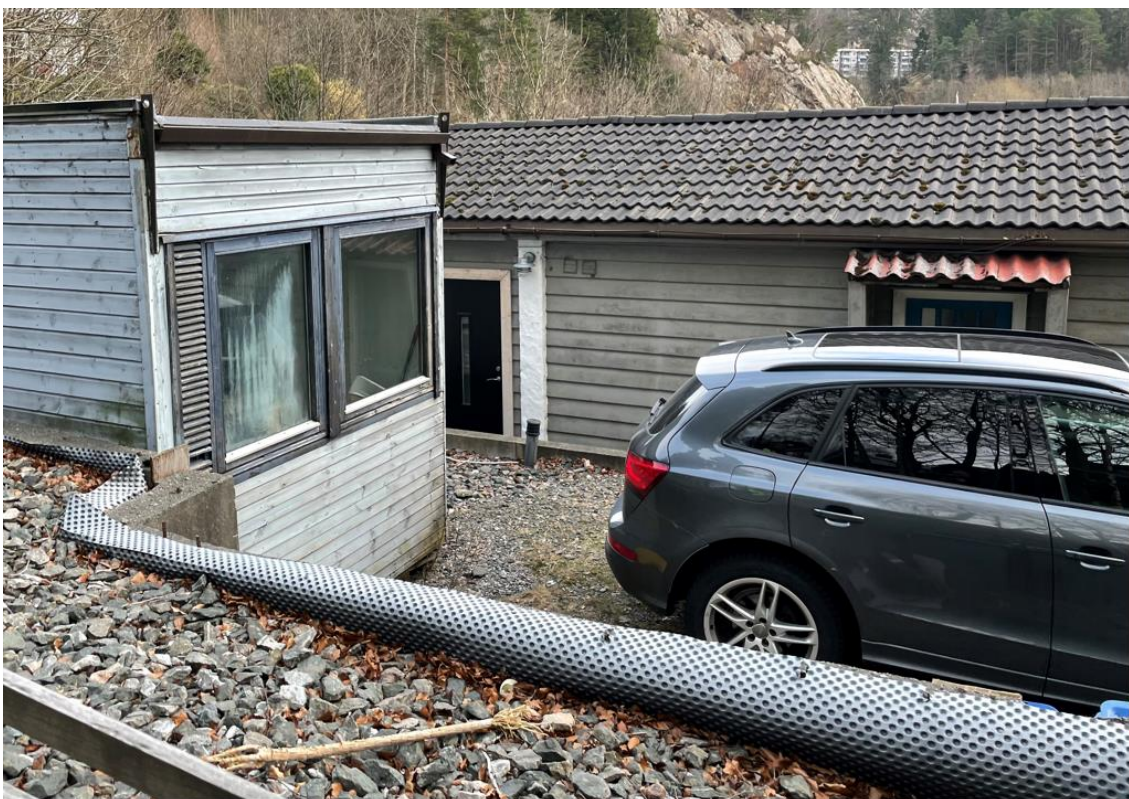
Figur 7-11 Fotografi av gårdsplass, brakkebygg og vestfasaden. Foto: Asplan Viak.
