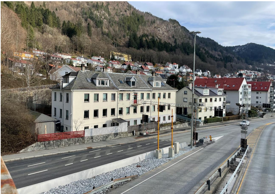
Figur 5-8: Fasade vest mot Sandviksveien. Foto: Asplan Viak.
