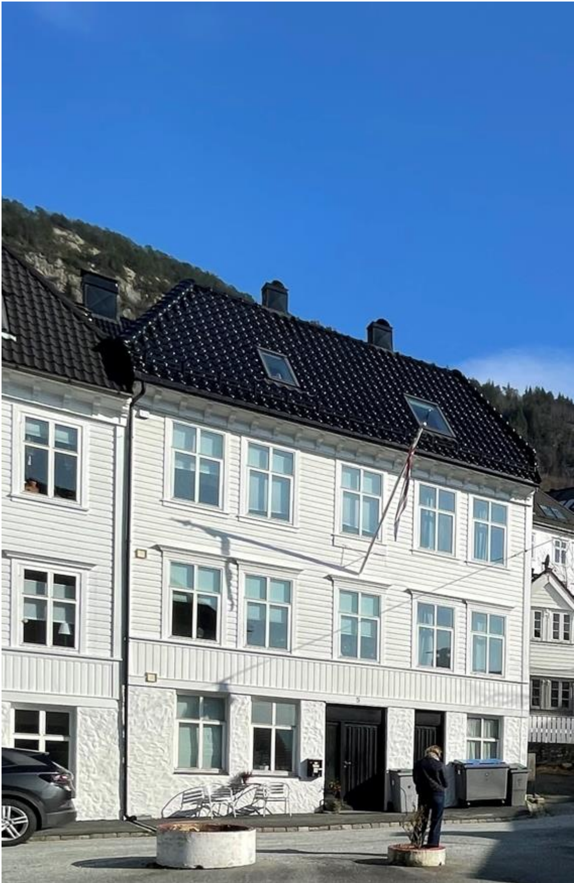
Figur 3-18: Bygningen sett fra vest. Foto: Asplan Viak.
