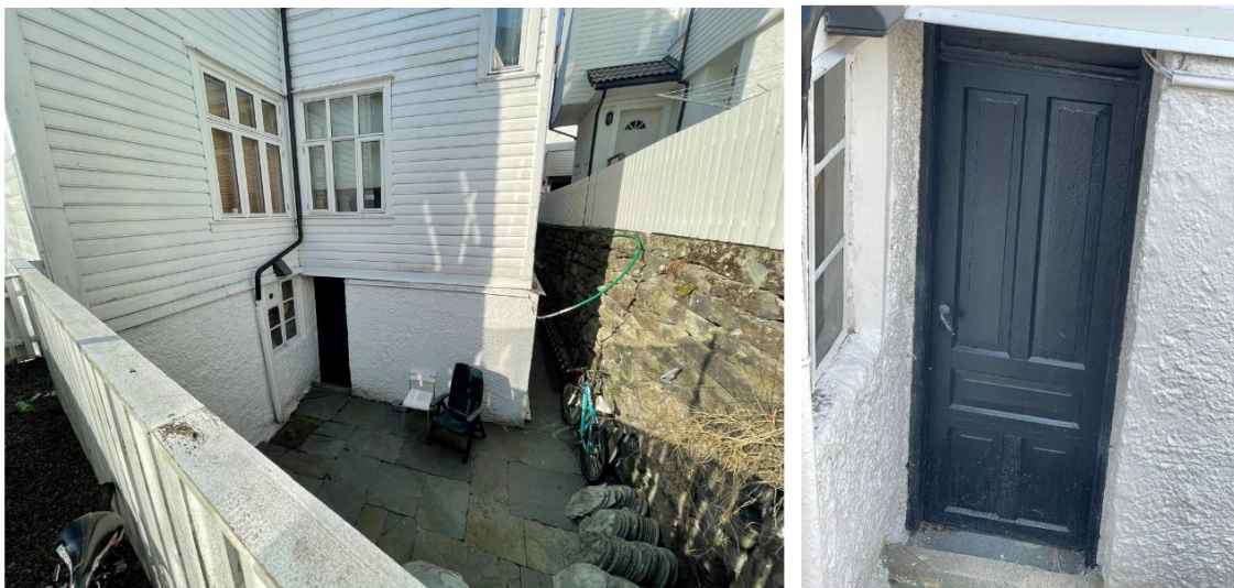
Figur 3-22: Bakgård. Originalt vindu og dør mot steinlagt bakgård til venstre. Original dør mot bakgård og ett bevart vindu til høyre (detalj). Foto: Asplan Viak.
