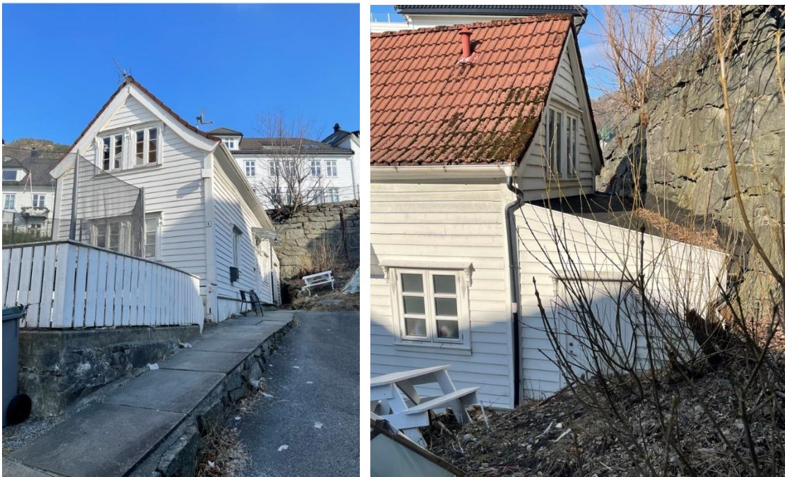
Figur 2-13 Bygningen sett fra vest og østfasaden med tilbygg inn mot muren mot Ekrebakken. Foto: Asplan Viak.
