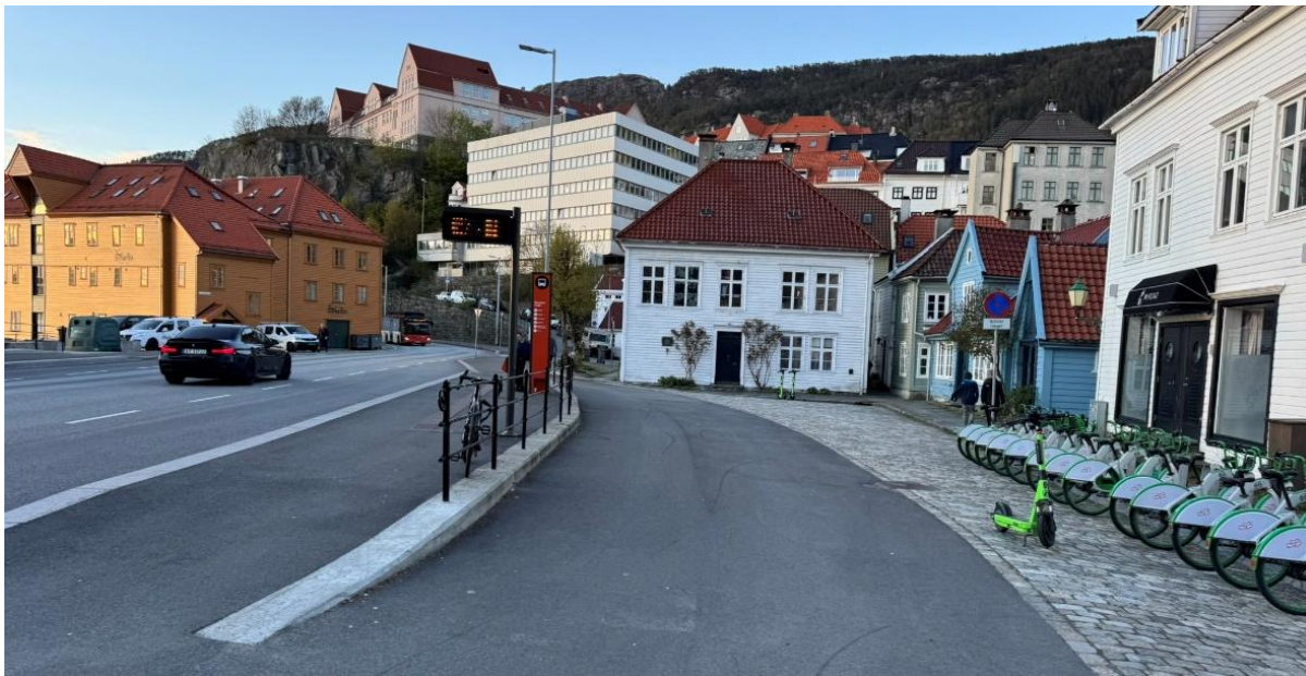
Figur 3-12: Holdeplassen på Skutevikstorget er i dag etablert med busslommer. Gang- og sykkelvei er lagt i bakkant av ventearealet, som er markert med rekkverk. (Foto: Norconsult)
