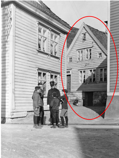
Figur 3-16: Ca. 1920-39. Bakersmauet 20 i midten bak. De to husene i forgrunnen er revet. Foto: Olai Schumann Olsen. (Billedsamlingen UBB: ubb-so-045)
