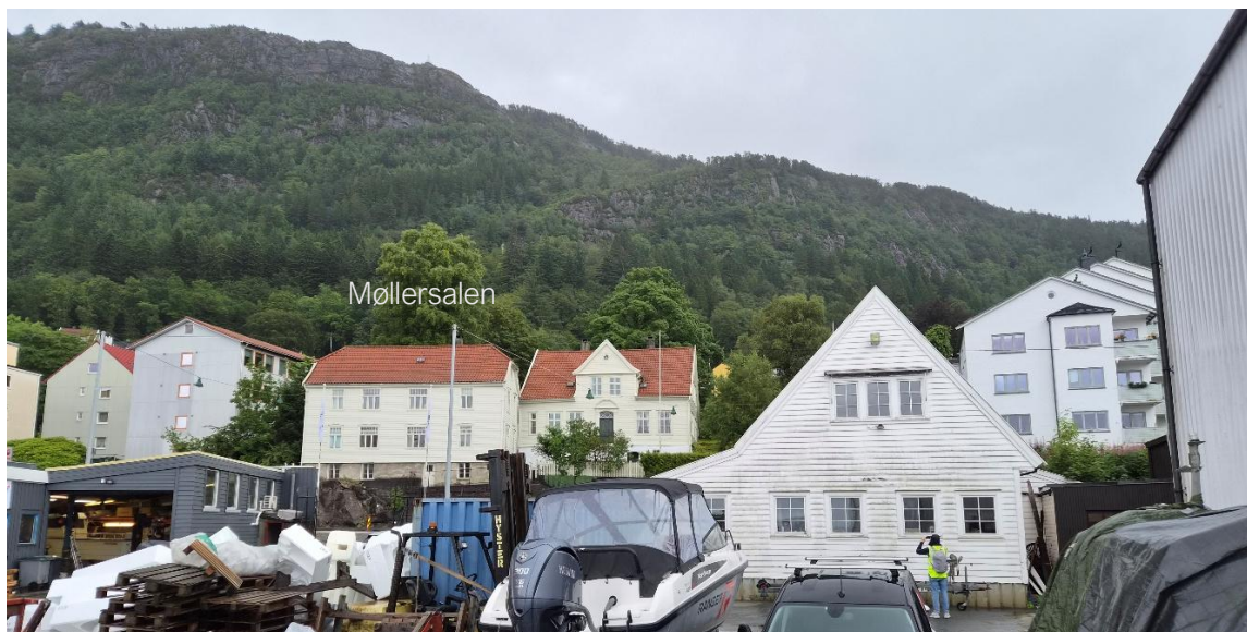
Figur 4-7 Sandviksboden 63A, fasade mot vest med Møllersalen i bakgrunnen.
