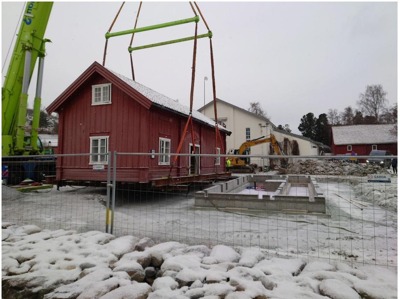
Figur 3-13 Eksempel på flytting av hus, her fra Skybergstuen på Gjøvik gård, 2023-12-07
