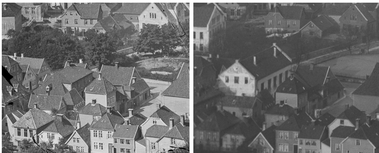
Figur 4-32: Utsnitt fra to Knudsenfotografier. Bildet til venstre er fra 1875-80, men bildet til høyre må være tatt i 1884 eller like etter. Gråskolen er revet, og erstattet av den større murbygningen som står i dag (ubb-kk-1318-2125, ubb-kk-nbx-0234).
