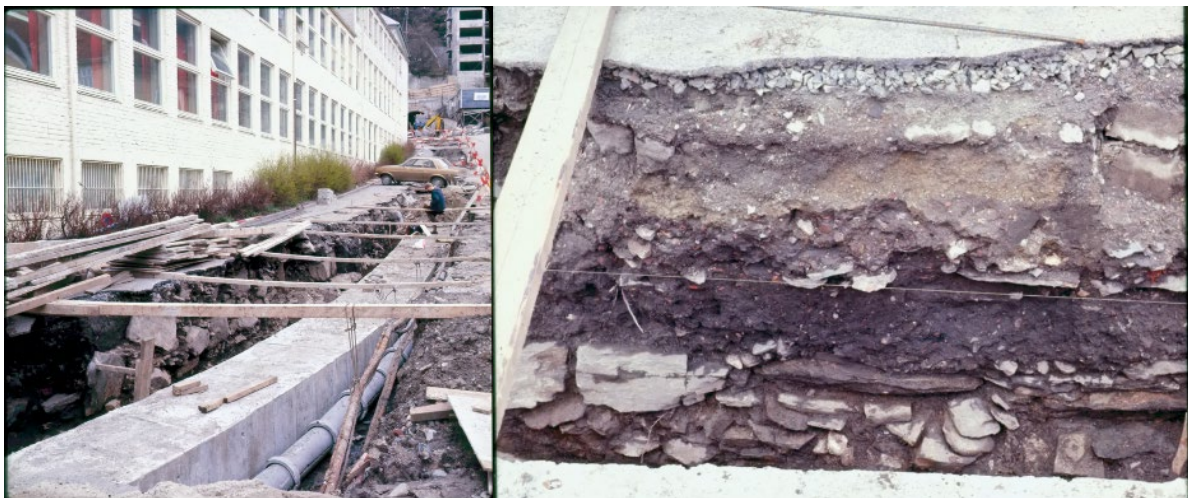
Figur 5-20 Bilder av muren i Heggebakken i 1972. Til venstre ser vi muren på innsiden av kabelkanalen, inn mot K-bygget. Bildet til høyre viser en detalj, sett fra kanten av kabelkanalen (Egill Reimers, Universitetsmuseet i Bergen, Fotobasen 006031 og 006035)
