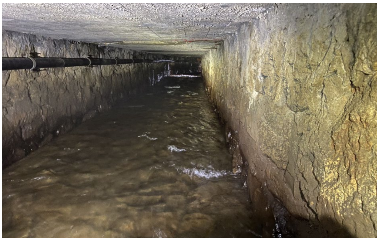
Figur 5-43. Nedre del av Mulelvkanalen i Sjøgaten. Kanalen har murte vegger og betongplate i topp. Overløpsledningen er klamret til kulvert vegg. Bilde Norconsult, 2026.
