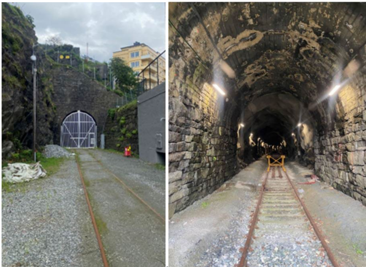
Figur 7-9: Portal med port sett fra Jernbanetomten (venstre) og første del av portal sett fra tunnelåpning (høyre). Sporene i dagen på Jernbanetomten er ikke i bruk i dag.
