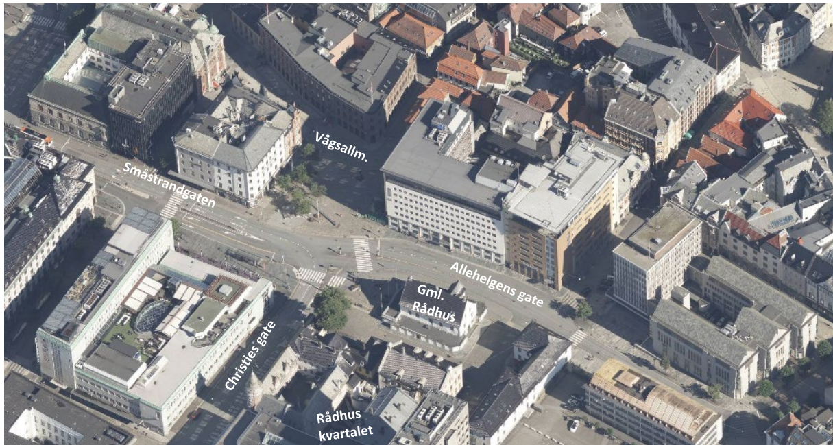
Figur 5-16 Bildet viser Småstrandgaten mot vest, Allehelgens gate mot øst, adskilt av Christies gate som kommer opp fra sørvest. Mellom de to sistnevnte ser vi Rådhuskvartalet med det Gamle Rådhuset, Stiftsgården, Brannstasjonen og Magistratbygningen. Øverst til venstre i bildet ser vi bevart city-arkitektur langs Vågsallmenningen (© 2026 Norkart AS/Geovekst og kommunene/OpenStreetMap/ NASA, Meti)
