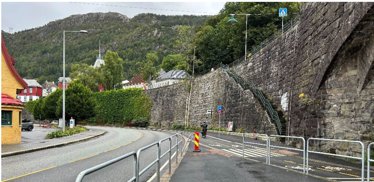
Figur 5-40: Ved Slaktehustomten (Sandviksbodene 1H). Sykkelvei med fortau på østsiden av veien og trapp som forbinder Sjøgaten med Nye Sandviksveien. Foto Norconsult.
