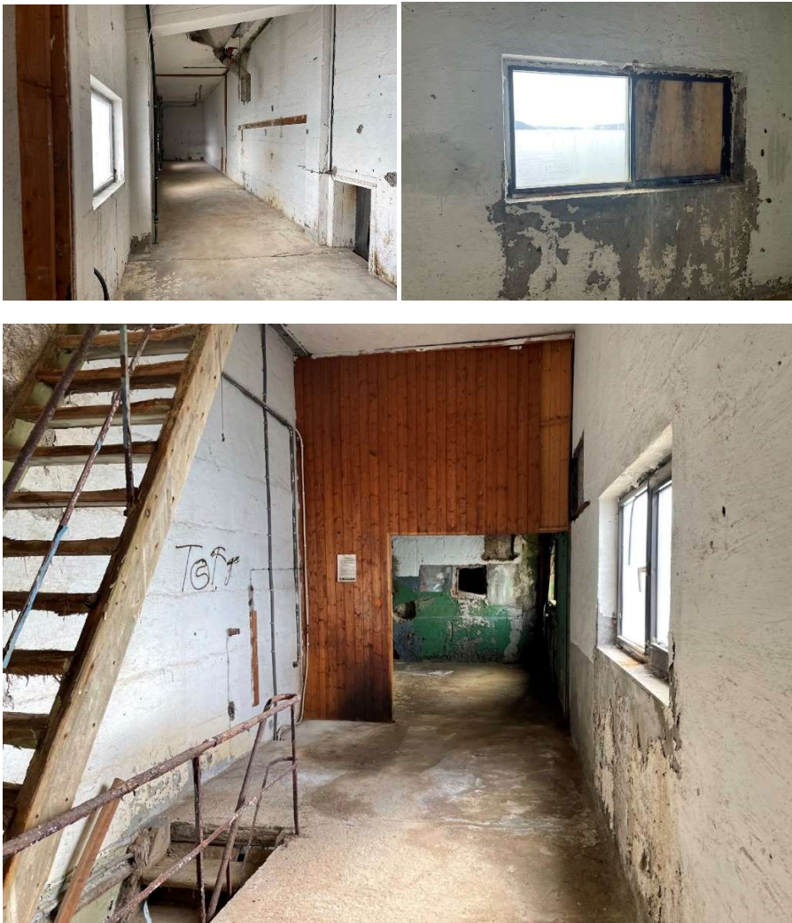
Figur 3-34: Korridor med tilstøtende rom. 2. etasje i den sørvestlige del av bygget.
