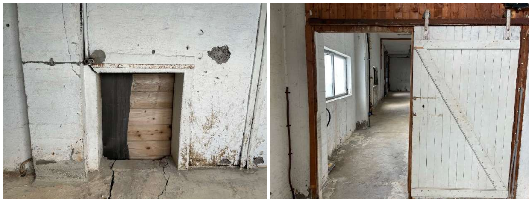
Figur 3-36: Detaljer fra 2.etasje i den sørvestlige delen av bygget. Inspeksjonsluke og dør. Norconsult 2021.
