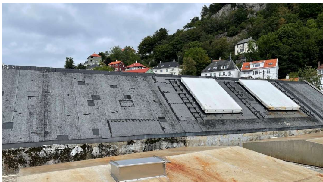
Figur 3-30: Bildet viser taket til nybygget, som ligger inntil betongsiloene. Norconsult 2021.
