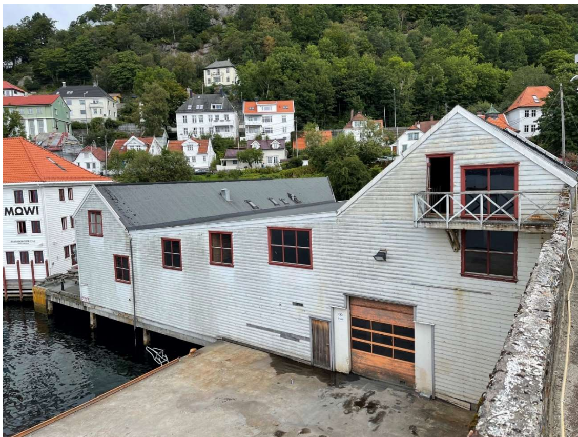
Figur 3-4: Fasade sør-vest. Bildet er tatt fra taket til betongsiloene. Foto Norconsult 2021.
