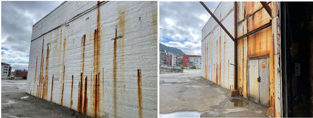
Figur 3-25: Fasade mot øst. Foto Norconsult 2021.
