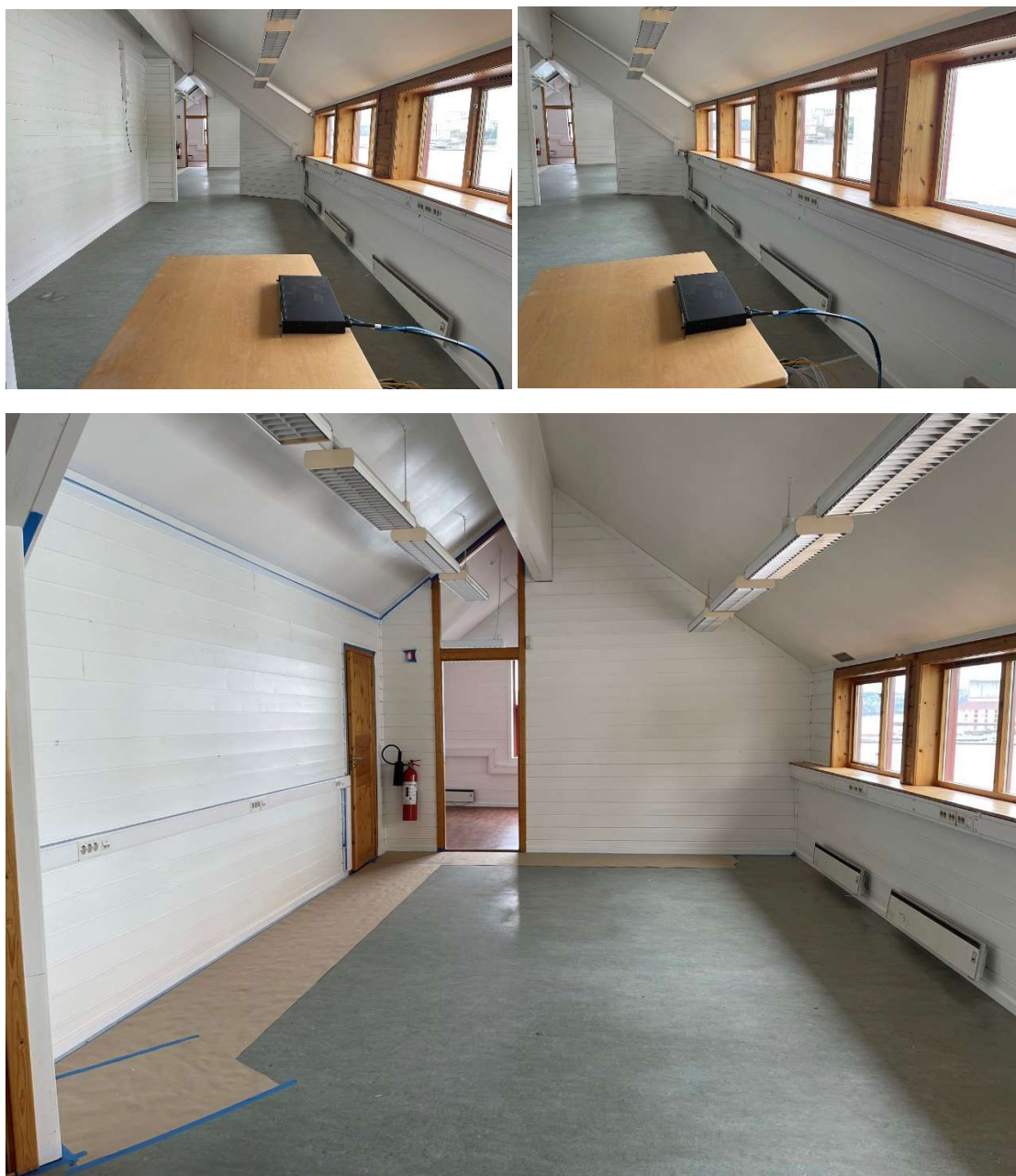
Figur 3-17: Kontorlokaler, 2 etasje nordre del av nybygget. Foto Norconsult 2021.
