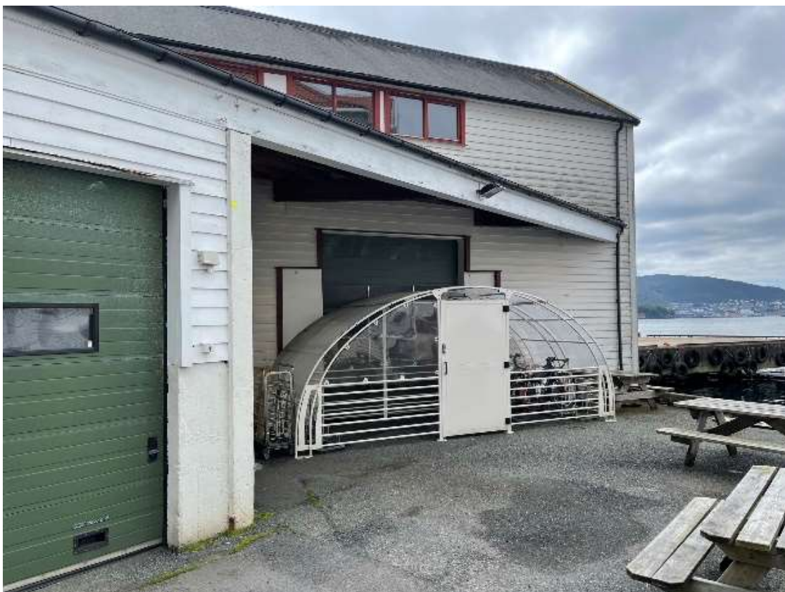
Figur 3-6: Fasade mot nord. Foto Norconsult 2021.
