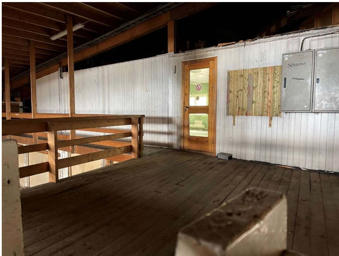
Figur 3-13: Mesanin/loftetasje med dør inn til personalrom. Foto Norconsult 2021
