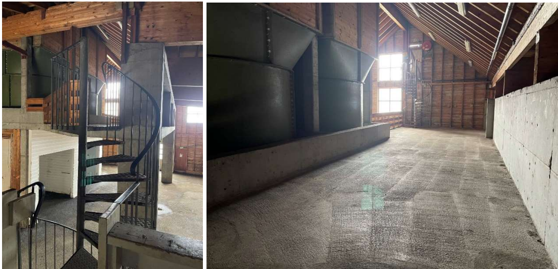
Figur 3-15: Trapp til mesanin2. Saltsiloer sees til høyre i bildet og i bildet under. Bakerst i bildet ser vi trapp til utgang balkong sørvest-fasaden, som også gir tilgang til taket på betongsiloene. Foto Norconsult 2021.
