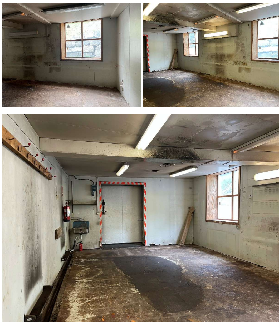
Figur 3-12: Verkstedsrom bakkant lagerhall/hovedhall mot øst. Foto Norconsult 2021.
