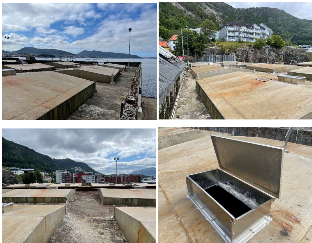
Figur 3-29: På taket av betongsiloen. Sett fra ulike vinkler. Bildene viser takoppbygg med luker til saltfylling og silorommene under. Foto Norconsult 2021.
