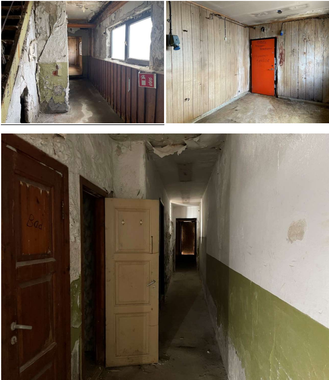
Figur 3-37: Underetasje i den sørvestlige delen av bygget. Gang/korridor med tilstøtende rom/kontor. Norconsult 2021.
