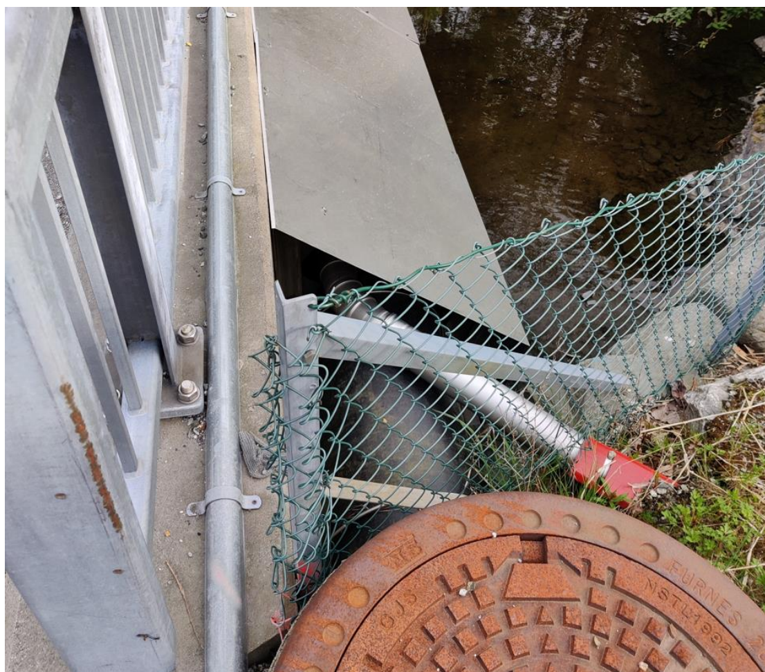
Figur 5: Eksempel på utforming av bruoppeng for vannledning over Dalelva.
