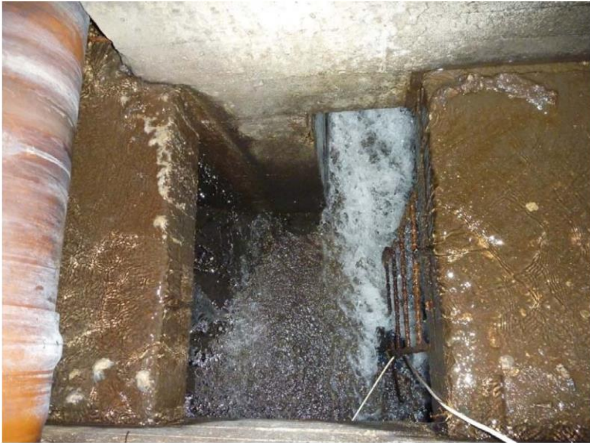
Bilde 3: Bilde fra eksisterende "spesialkum" før sjakt til flomtunnel. (Kilde: «VA-rammeplan, Åsane sentrum», Multiconsult, 2012)
