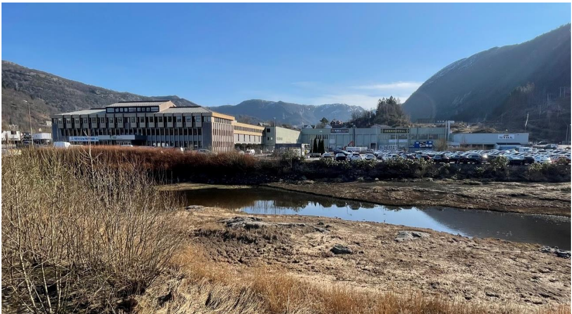
Figur 3-14: Anlegget sett mot sør-øst. Foto: Asplan Viak.
