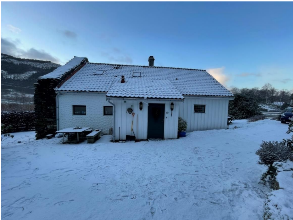
Figur 5-12 Fasade nord. Foto: Norconsult.
