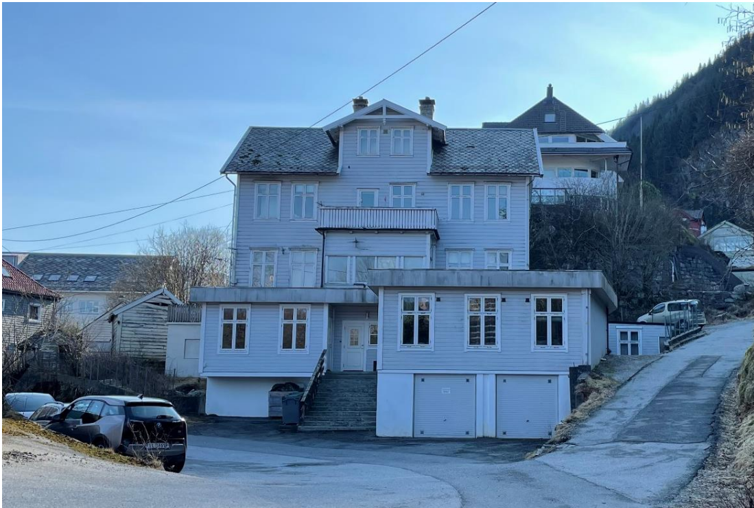
Figur 2-16: Fasade nord mot Eidsvågveien. Foto: Asplan Viak.
