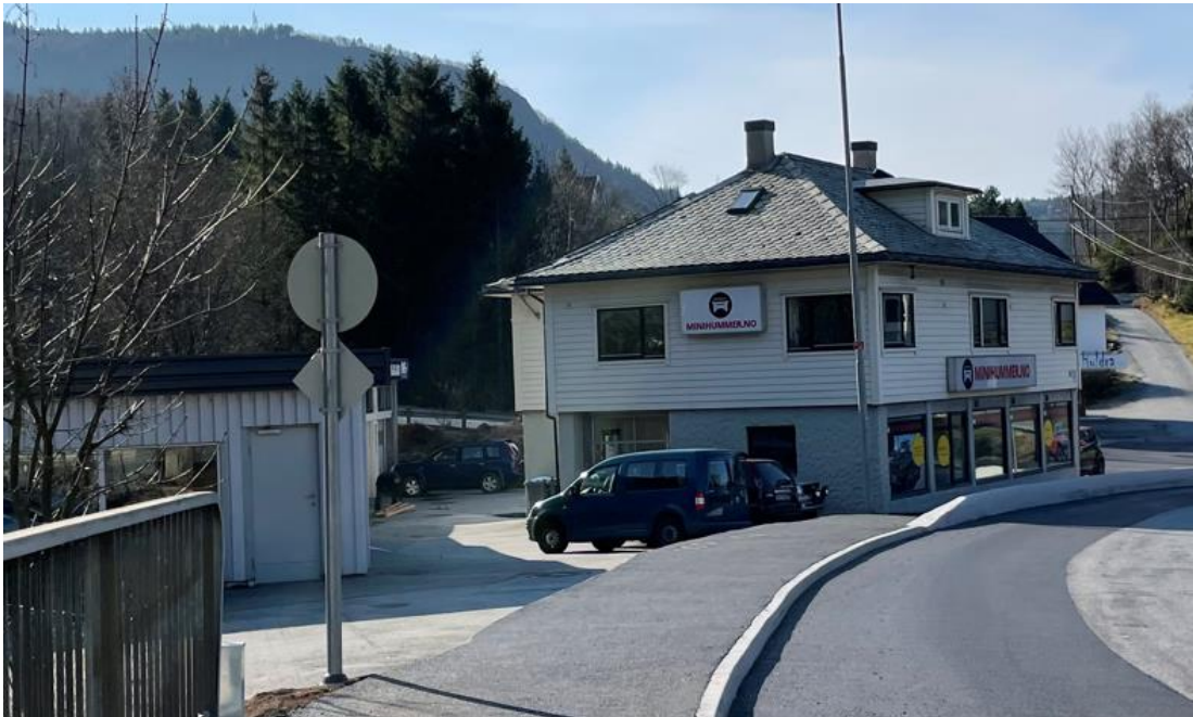
Figur 6-9 Fotografi av fasade nord, tatt fra Ervikveien. Foto: Asplan Viak.
