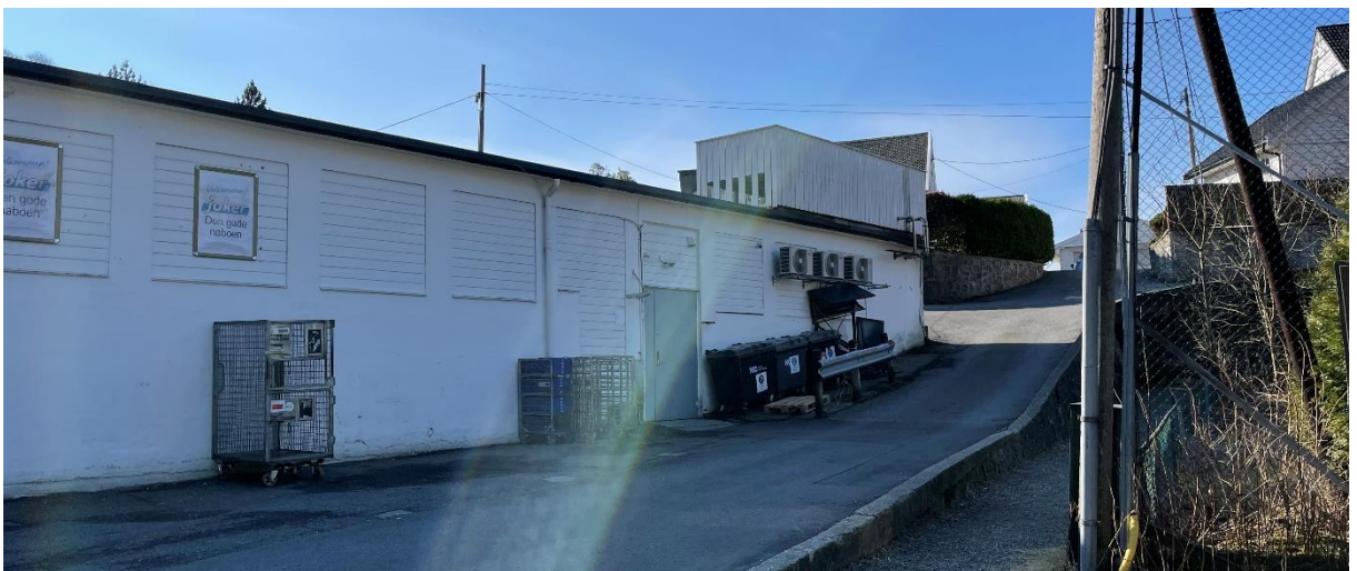
Figur 7-13 Fotografi av 72, fasade nord.
