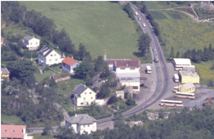
Figur 7-5 Garasjeanlegget til Åsane Billag til venstre (i rødt), med Ervikveien 67 i forkant (grønn sirkel). Anleggelsen av dagens E39 medføre at garasjene til Åsane Billag til høyre i bildet måtte rives. Flyfoto fra 1965 av eiendommen sett fra sør.
