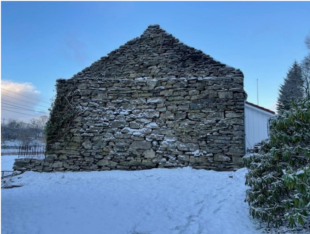
Figur 5-13 Fasade mot øst. Foto: Norconsult.
