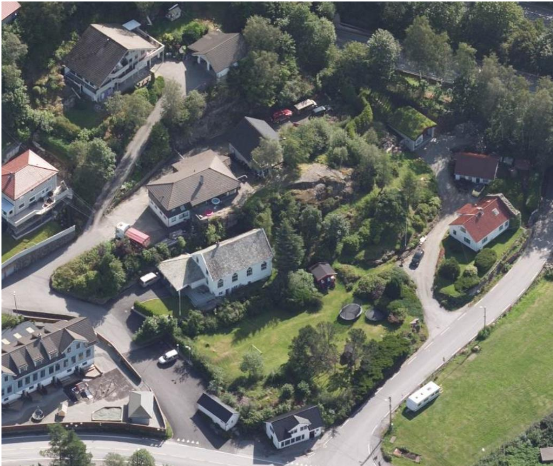
Figur 5-5 Oversiktsbilde som viser miljørammen. Selvikveien 6 lengst til høyre i bildet.
