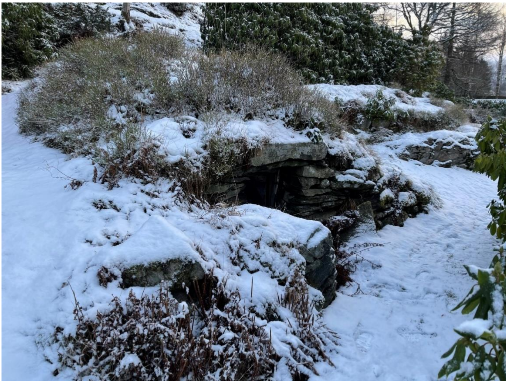
Figur 5-16 Jordkjeller på sti mellom våningshuset og det tidligere bedehuset. Foto Norconsult.
