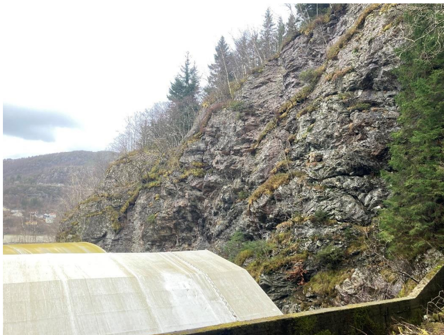
Foto 5: Oversikt over vestvendt skråning sør for påhuggsområde. Foto mot NØ.
