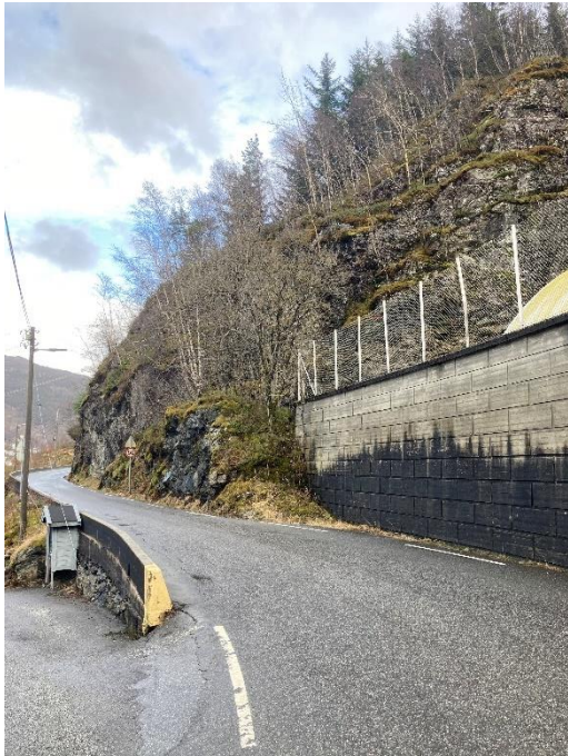
Foto 8: Skjæring langs Jordalsveien. Foto mot NØ.
