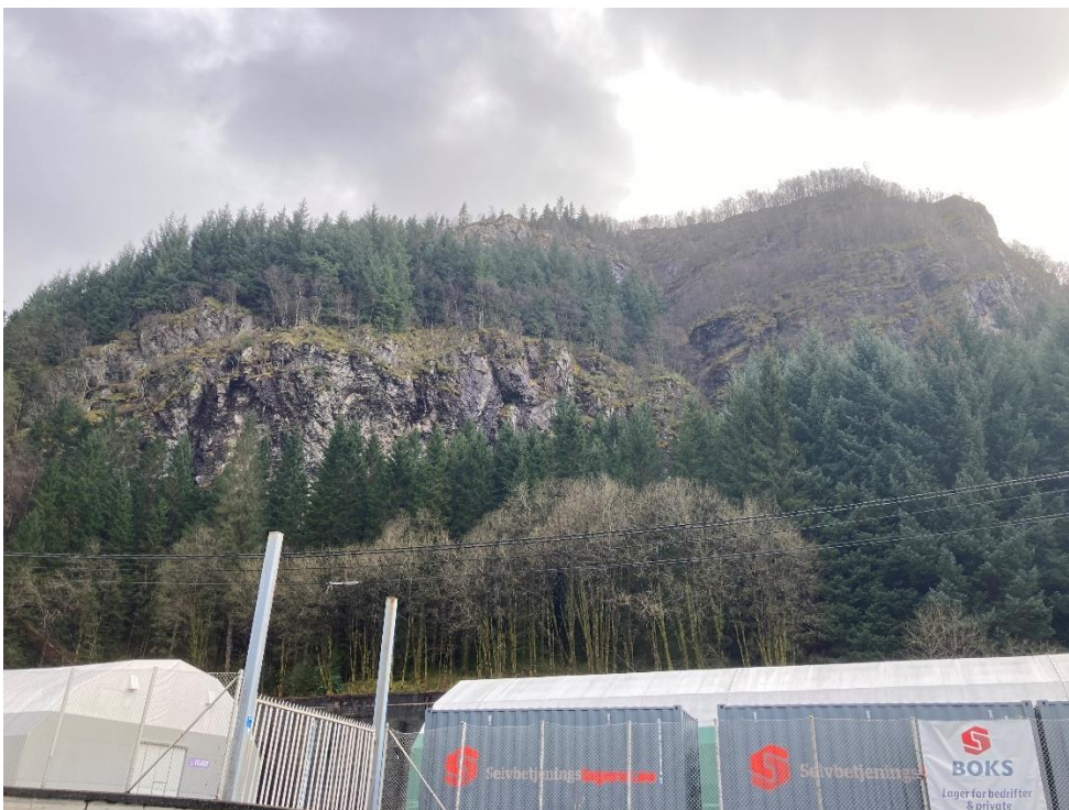
Foto 2: Steile skrenter i bakkant av kartleggingsområdet. Foto mot sør-øst.
