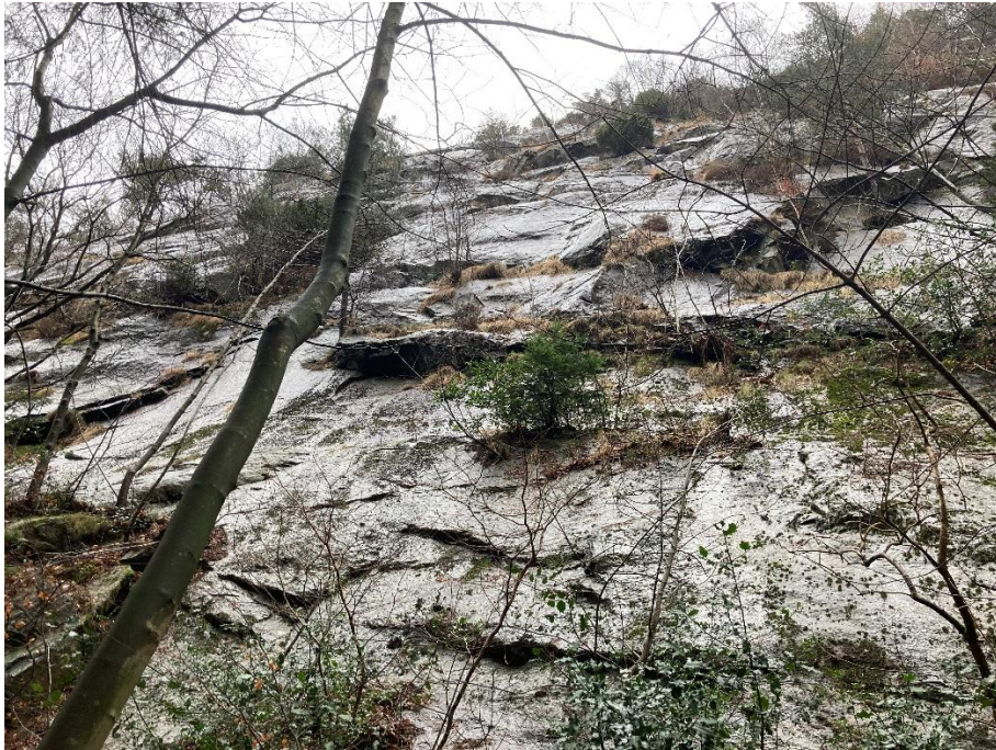
Foto 14: Bratt skrent ovenfor Fjellveien. Tegn på eksfoliasjon av bergflak. Foto mot NØ.
