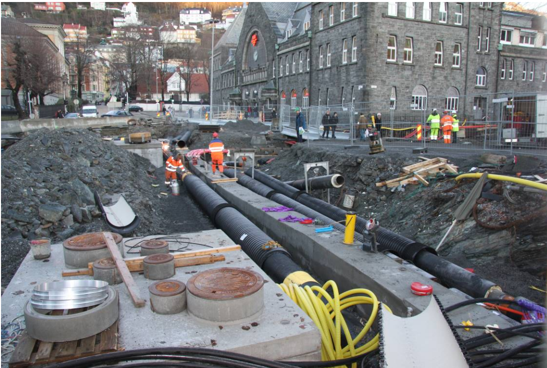
Bilde av arbeidene i krysset Kaigaten og Strømgaten (2008).
