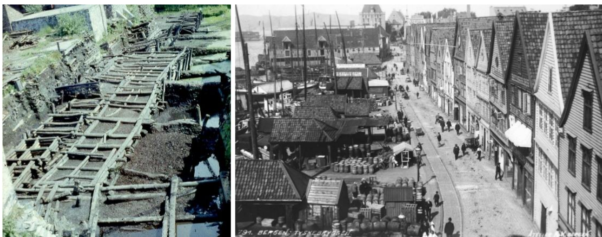
Figur 5.12: Til venstre den såkalte kong Sverres kai i bruk i perioden 1170-1198. Ved senere utfylling i Vågen inngikk kaien som fundament for bebyggelsen. Til høyre Bryggen mellom 1913 og 1920 (t.v.: Middeldalersamlingen, universitetsmuseet i Bergen, t.h.).
