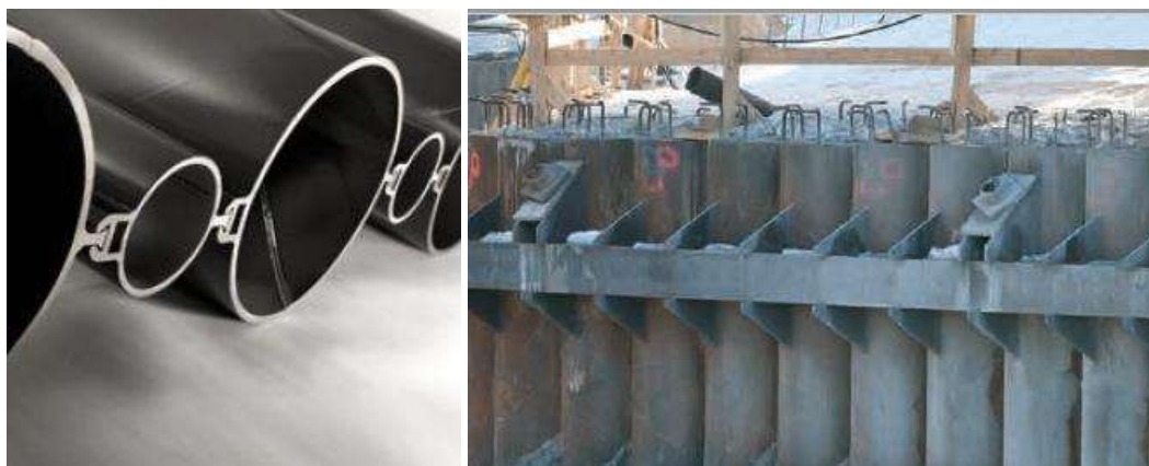
Figur 3-7 Til venstre: Rørpeler med skjøteløsning, her vist med varierende pelestørrelse for tilpasset stivhet/motstand kapasitet. Til høyre Horizontal forankring av rørspuntvegg
