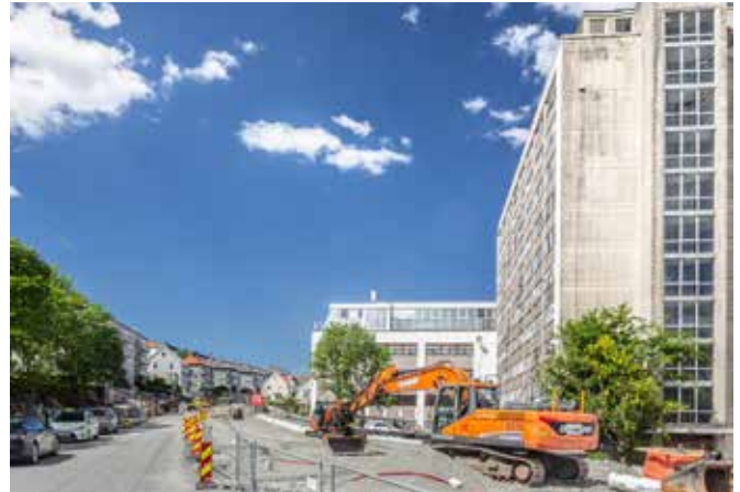
Under arbeid: Sykkelveg med fortau samt trolleybusslinje i Carl Konows gate. Foto: Silje Drevdal
