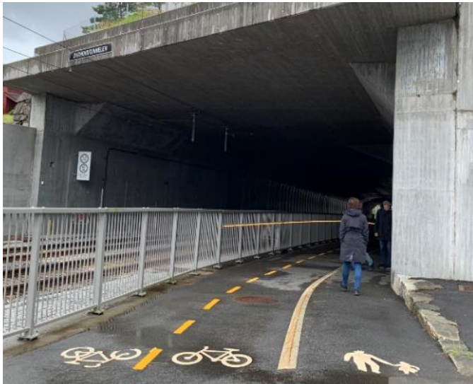
Figur 4-83: Rekkverksløsning bybanetunnel og sykkelrute Sandsli. Bredden på sykkelvei og fortau er smalere en planlagt hovedsykkelrute gjennom Eidsvågtunnelen.
