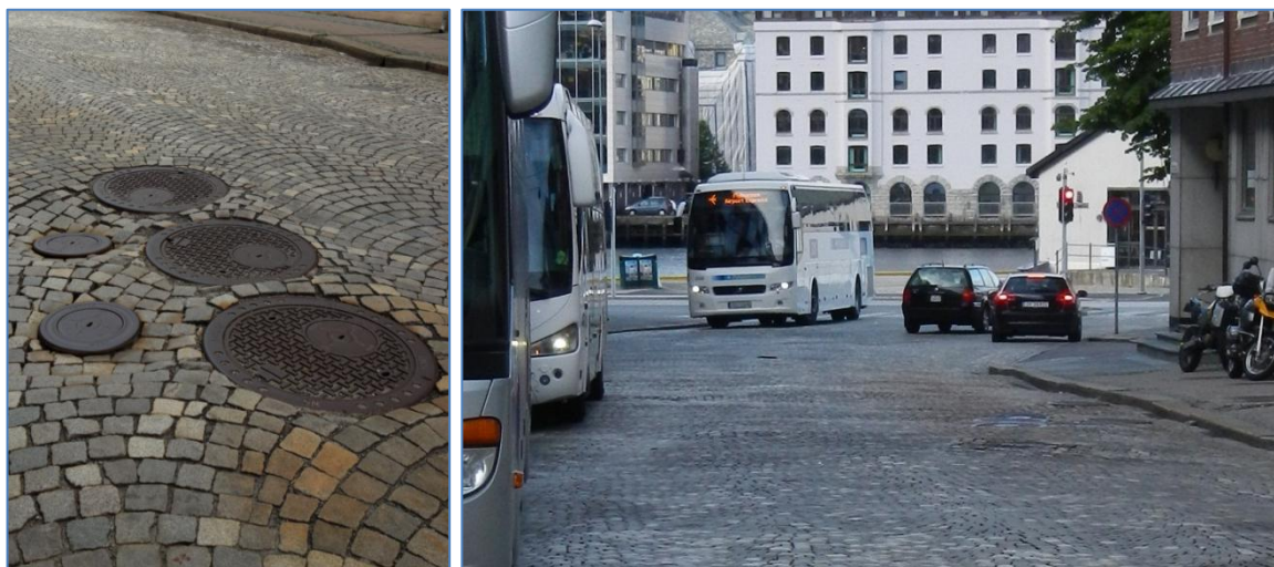
Figur 4: Bekkalokk i gata ut for Sandbrogaten 5, bekkalokk og gatedekke utenfor Bradbenken 1.
